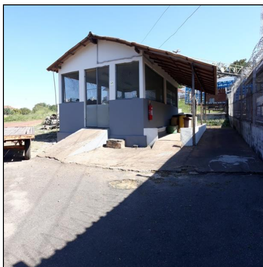
Figura 1 - Central de resíduos – área externa
