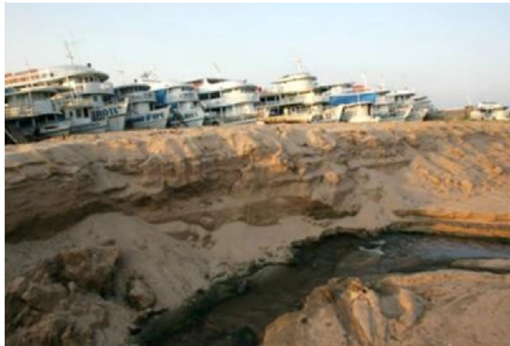
Figura 5 - Vista da área das obras de ampliação do Porto de Santarém. Detalhe para a associação de solos Neossolos Flúvico Tb Estrófico e Neossolos Quartzarênicos
